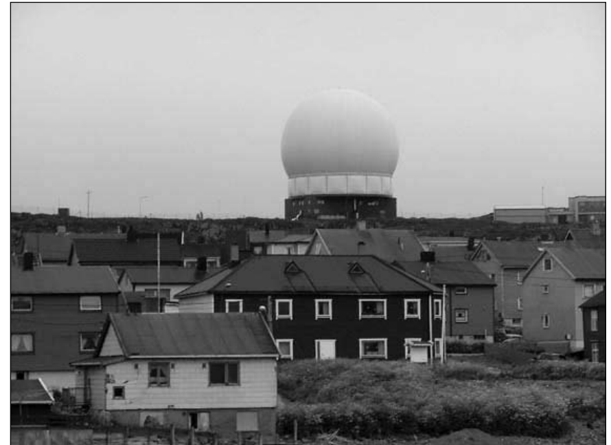
Vardö radaranläggning i Nordnorge.
